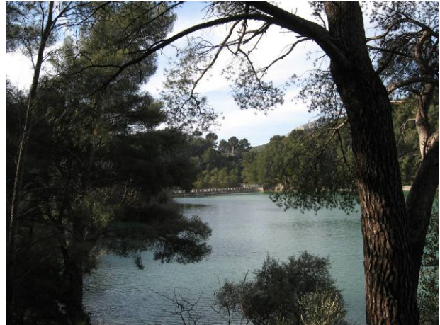
Le barrage de Dardennes photo Sogreah
