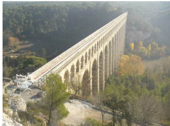
Viaduc de Roquefavour sur le canal de Marseille Photo B.Couvert
